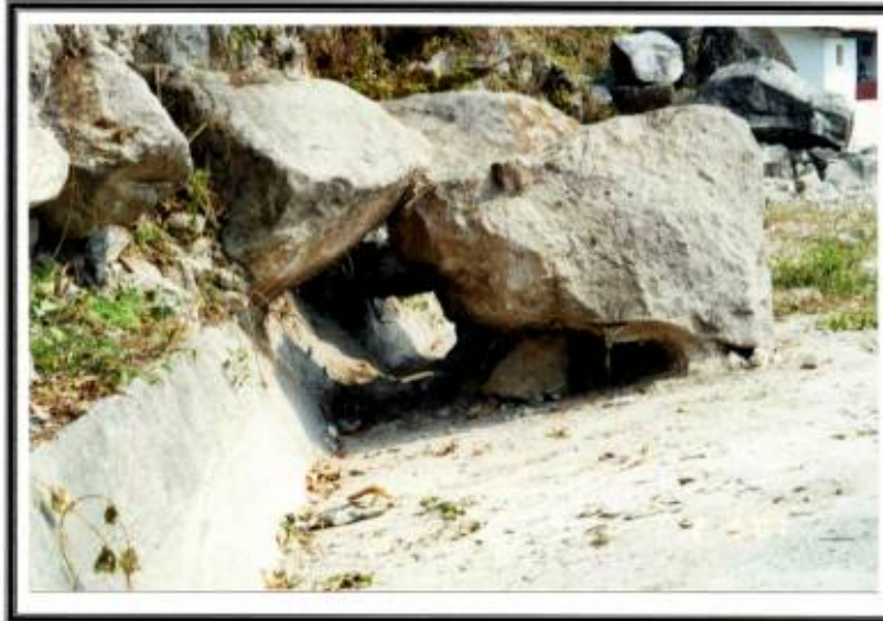
Apertura en roca sobre cuneta revestida, para permitir el paso del agua
