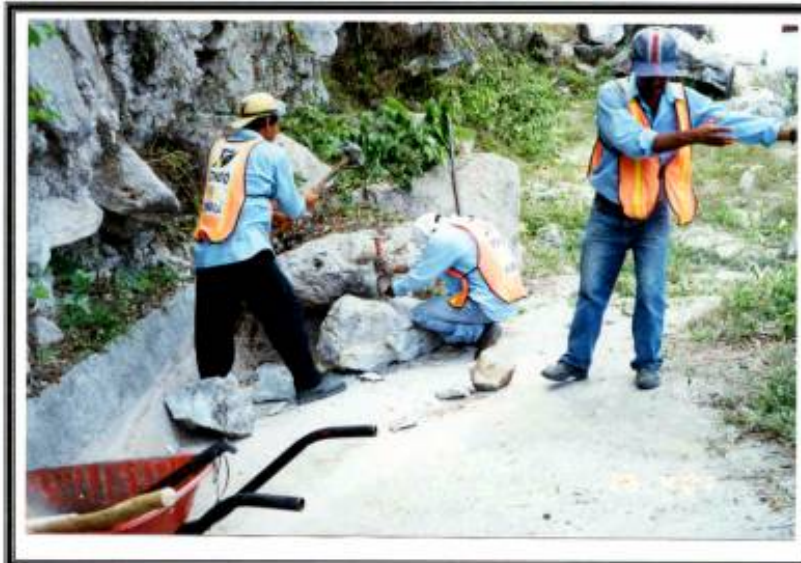
Retiro de rocas de cuneta revestida
