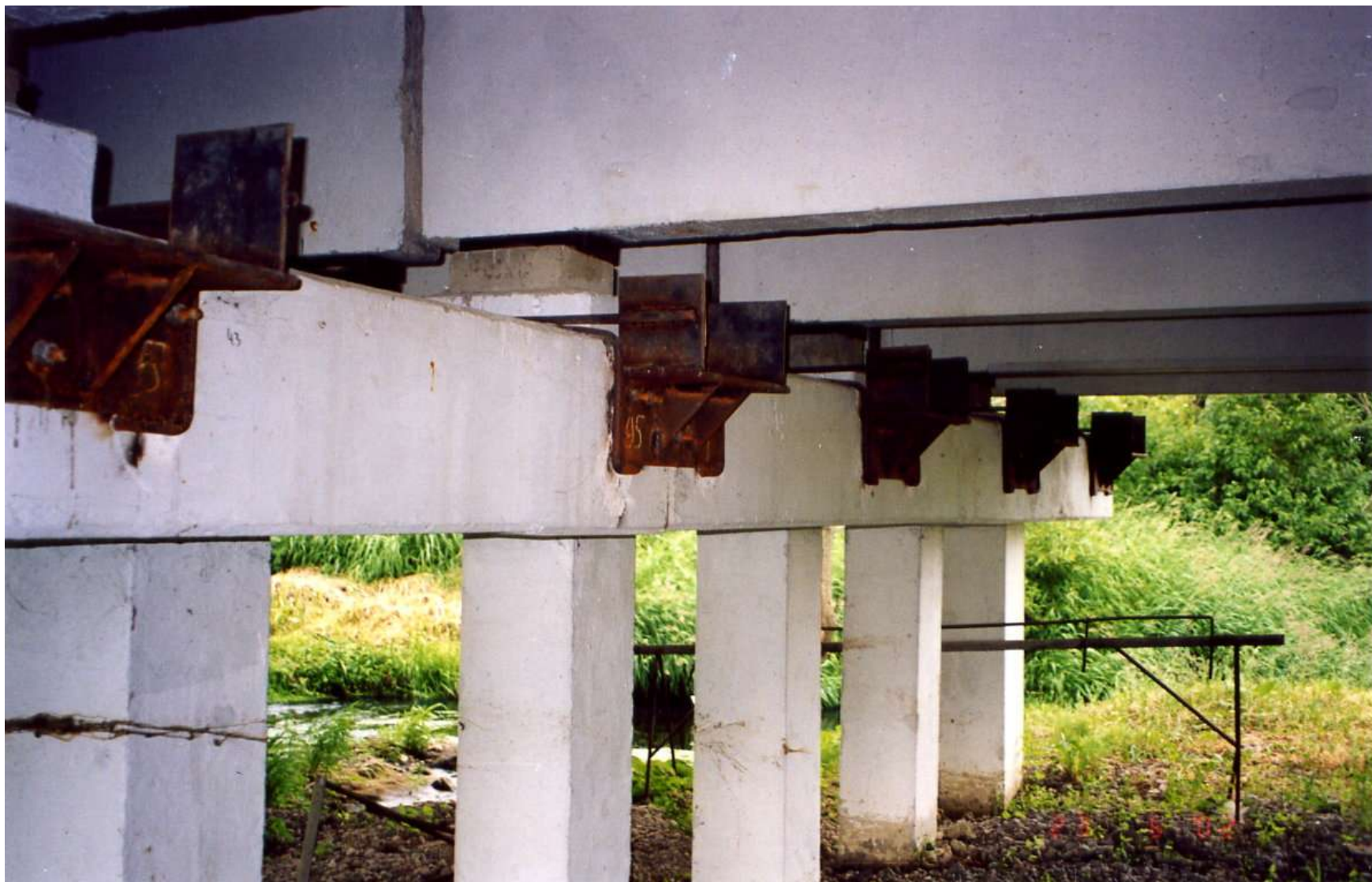
Подъёмка с заменой опорных частей
