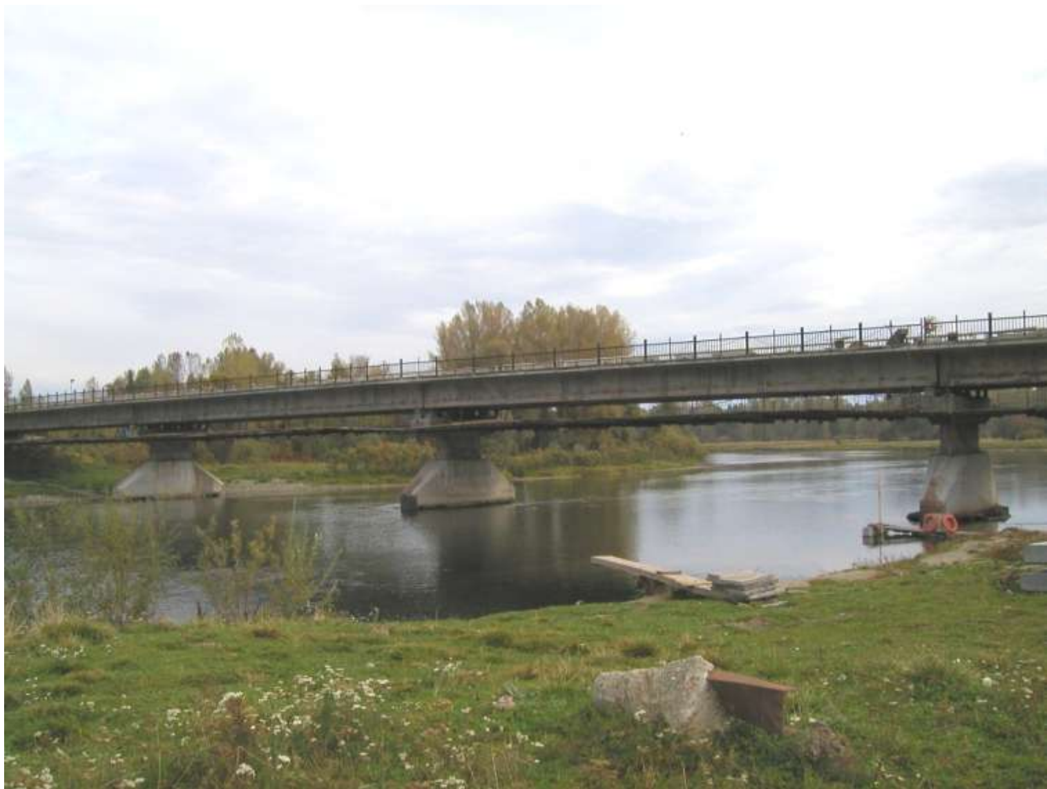
Усиление ж/б балок \ell = 24\text{м} , р. Оять
