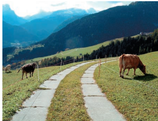
Bild oben: Spurweg mit vorfabrizierten Elementen Rumadetsch, Gemeinde Scheid GR, 1996 Bild unten: Spurweg mit vorfabrizierten Elementen Mathon GR, 1991
